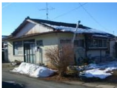
東和三六山第一住宅
