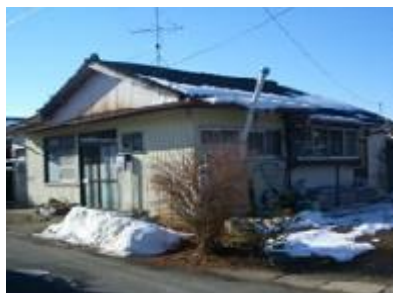
東和三六山第一住宅
