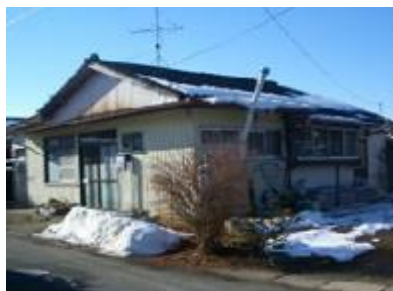
東和三六山第一住宅
