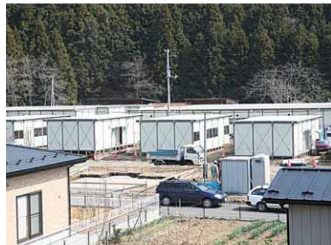
横山地区に建設された仮設住宅
