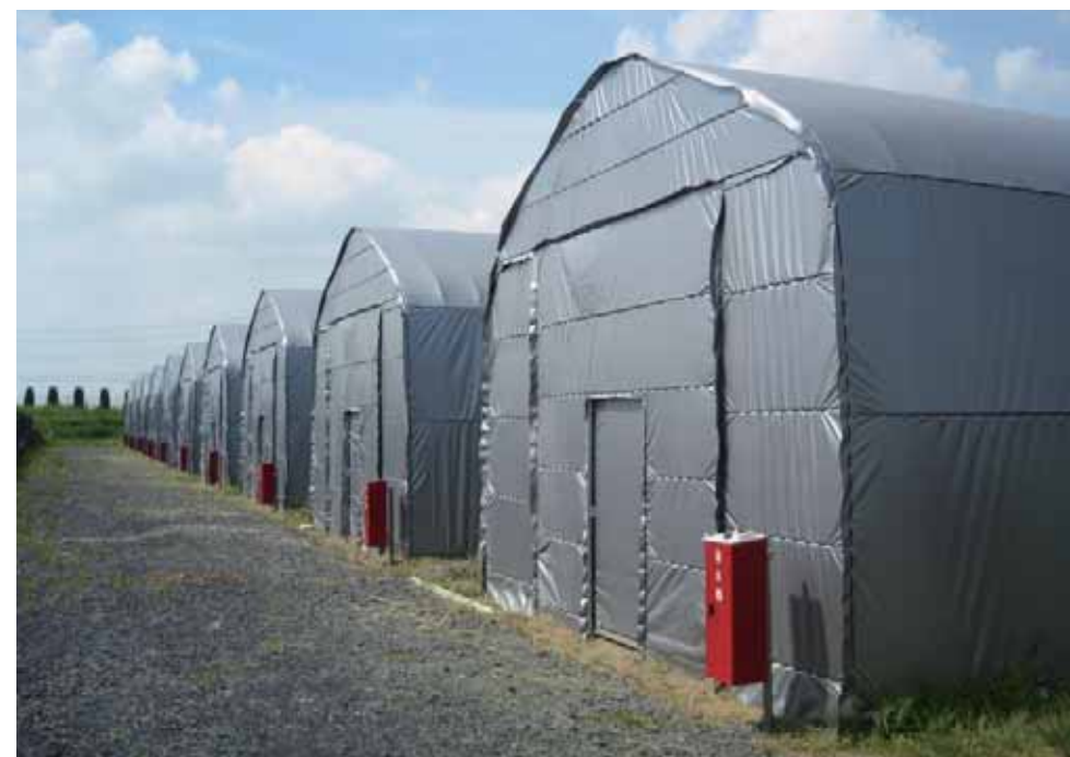
汚染稲わら一時保管庫
