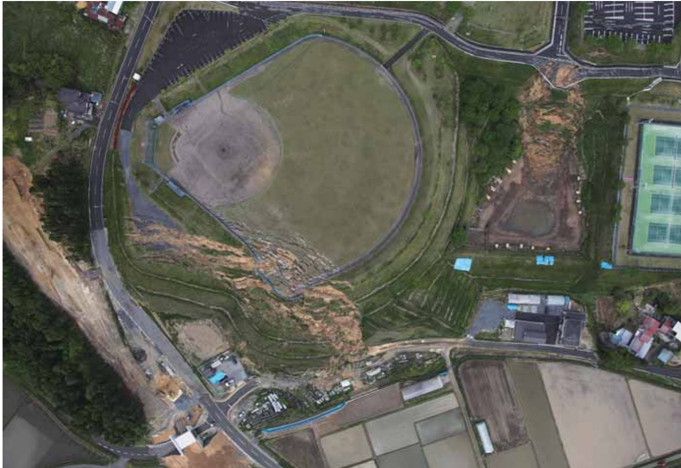
崩落した東和総合運動公園
