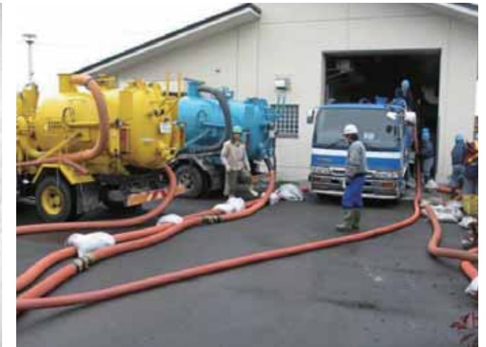
■迫中継ポンプ ポンプ車で汚水を汲み出している状況
