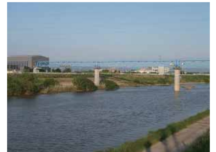
耐震化し復旧した迫川水道管
