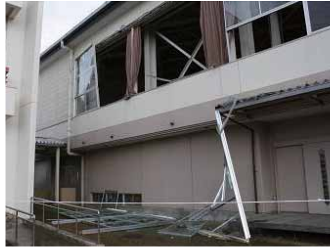
石越小学校体育館
