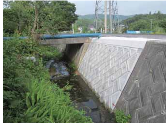
館の下川(東和町米川)復旧状況
