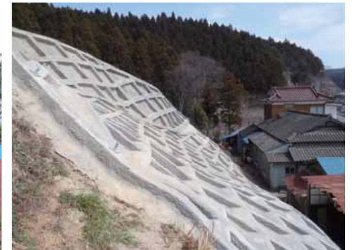
がけ崩れ対策完成(津山町田高畑の2)
