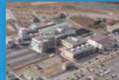
消防防災センター
