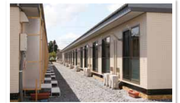
南方地区に建設された仮設住宅
