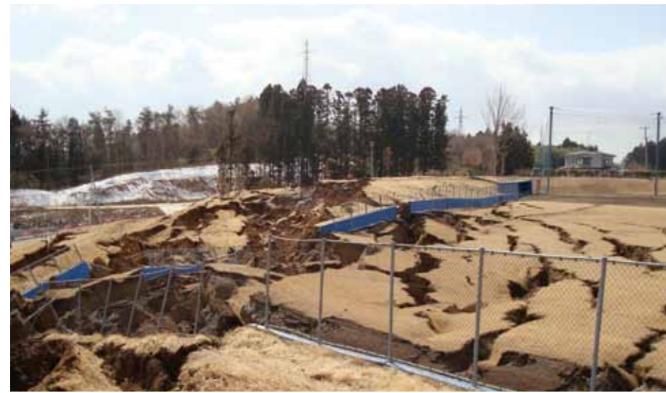
←大きく地面が裂け崩壊した 東和総合運動公園の野球場
