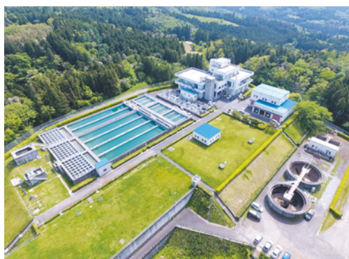
上水道の基幹施設となる保呂羽浄水場
