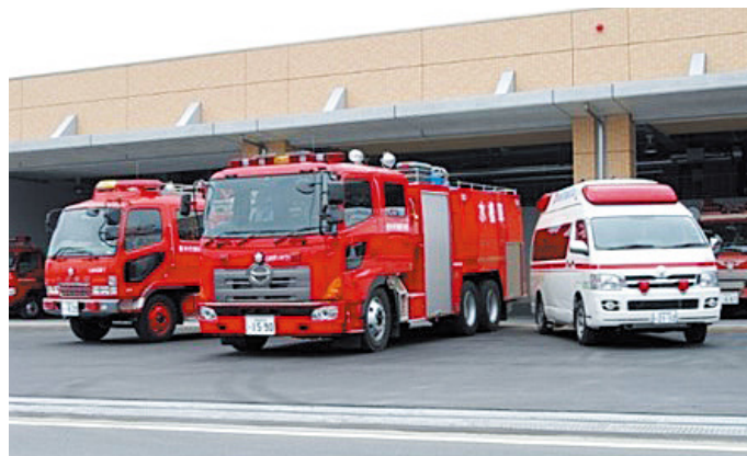
安全・安心の要、消防防災センター
