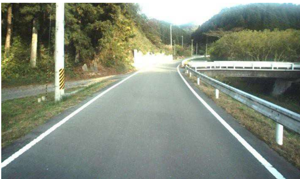
写真 4.3 軽度の劣化区間の一例
