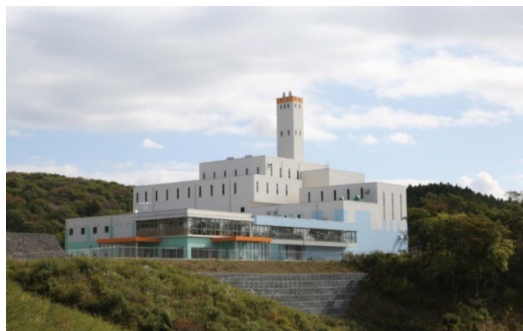
令和元年12月に稼働を開始した新しいクリーンセンター
