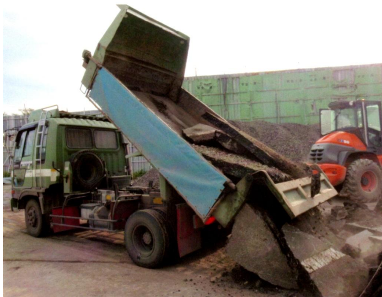
工事現場発生のアスファルト廃材を産業廃棄物中間処理施設へ運搬処理している状況の写真
