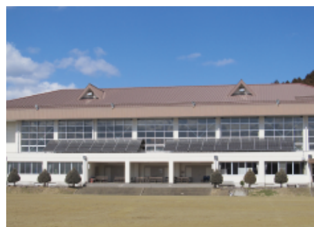
太陽光発電設備を設置している 市内指定避難所
