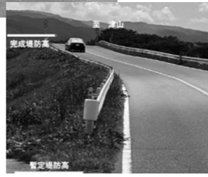
完成が急がれる暫定堤防高
