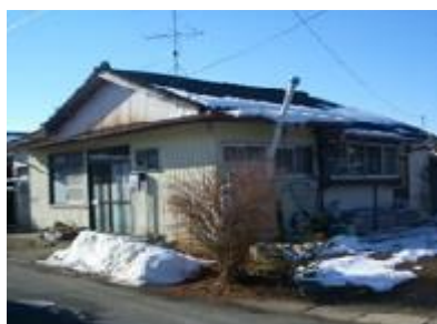
東和三六山第一住宅
