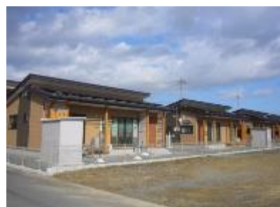
豊里横町住宅（災害公営）
