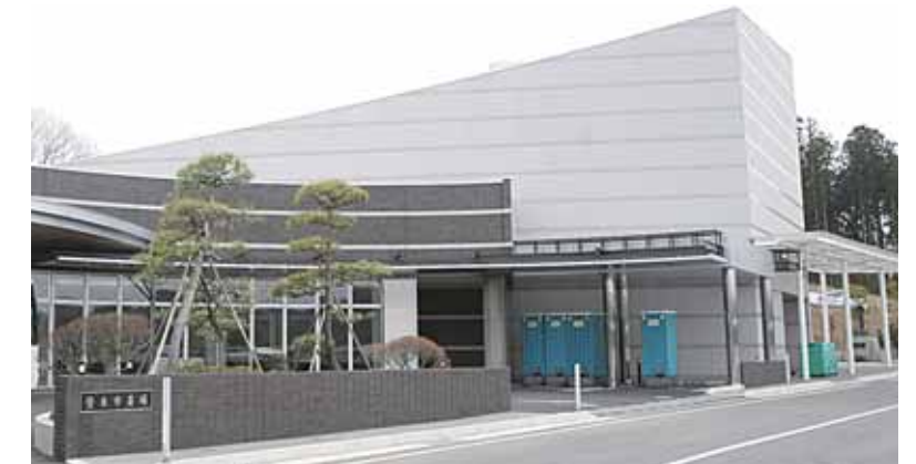
登米市斎場 震災時屋外には自家発電機と仮設トイレが設置された
