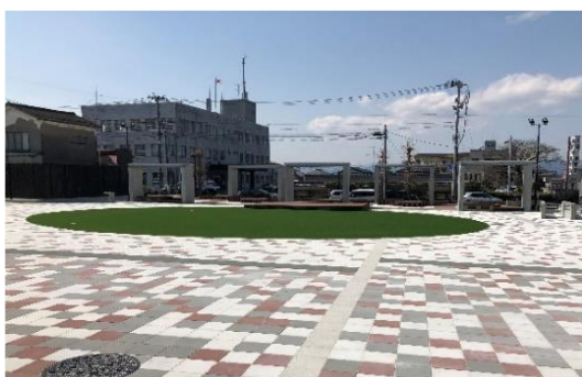
図：災害対応機能も備えた防災広場 (須賀川市庁舎)
