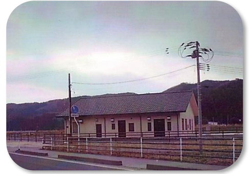
生活環境の向上に繋がる農業集落排水施設
