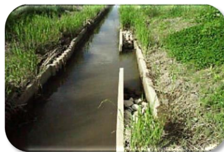
環境配慮工法による排水路整備 (生き物にやさしいお助け水路)
