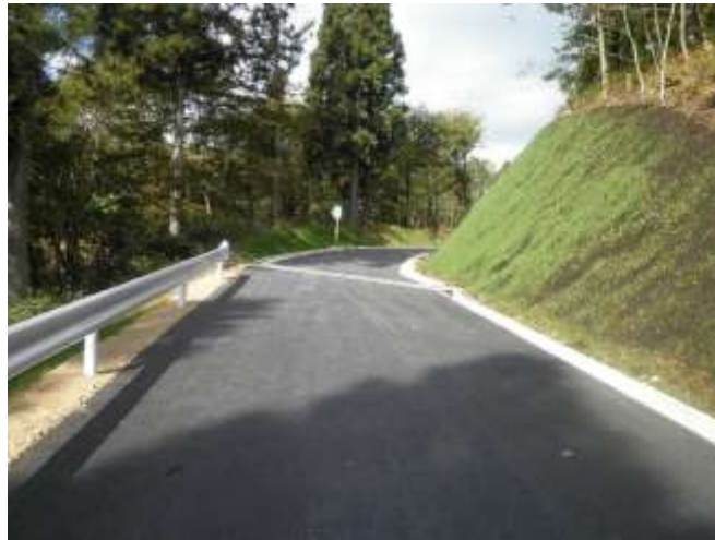
整備が進む「ふるさと林道登米東和線」
