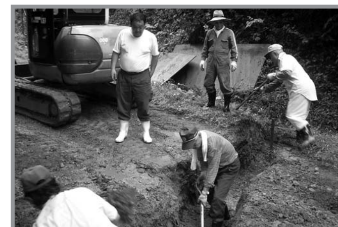
▲横断側溝の敷設など、地域の住民が協力し市道を整備しました
