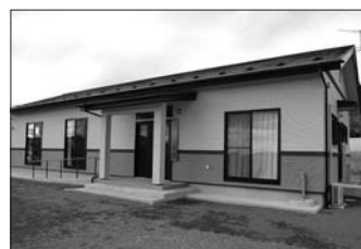
▲沢田行政区で整備した集会施設「沢田公民館」
