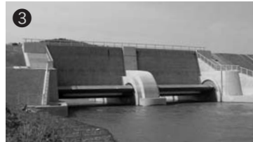
③端部の円盤を回転させ水門ゲートを動かす「鴉波水門」
