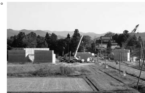
下部工工事の進む日野渡橋
