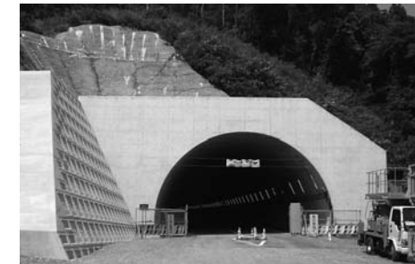
鴛波トンネル南側坑口の様子
