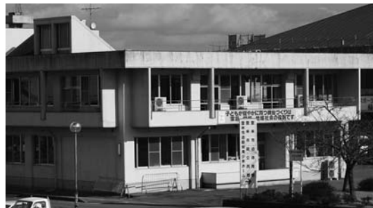
公共施設の施設使用料を4月から改定します（写真は迫公民館）
