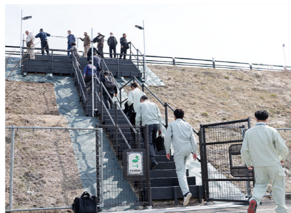
緊急時は、扉の透明なアクリル板を強くたたいて壊し、内側のドアノブを回すと鍵がなくても開けることができます。
