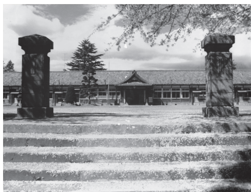
昭和7年に完成した旧錦織小学校
