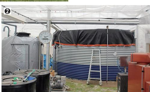
①施設規模はハウスと機械室を合わせて約22アール②貯水タンクは60トン、雨水と井戸水を使用。肥料や薬剤の散布も自動調整③施設内の環境をシステムで管理。スマートフォンでの遠隔操作も可能
