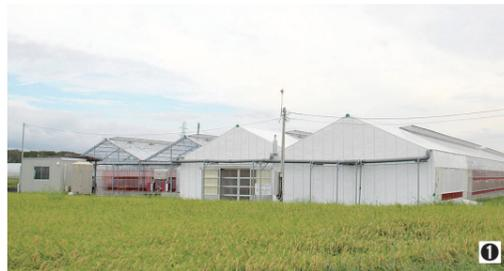
①施設規模はハウスと機械室を合わせて約22アール②貯水タンクは60トン、雨水と井戸水を使用。肥料や薬剤の散布も自動調整③施設内の環境をシステムで管理。スマートフォンでの遠隔操作も可能
