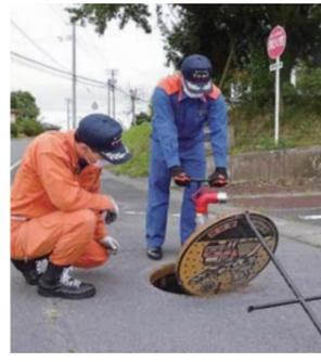
市消防署では、災害時の使用に備えて消防栓バルブの開閉状況、防火水槽の水量など、消防水利の点検を実施します。車両の通行などには十分注意して行います。市民の皆さんのご理解、ご協力をお願いいたします。
