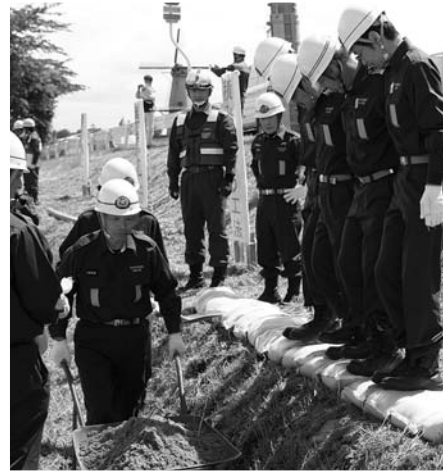
堤防からの越水を防ぐ積み土のう工法
