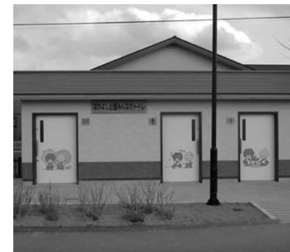
▲新設された「なかよし公園（中田）」のトイレ
