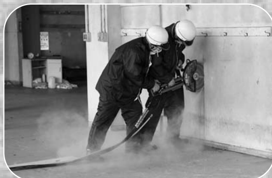
▲油圧式カッターでコンクリートの壁を切断する隊員
