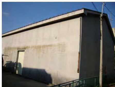
植物工場として改修される建物。 水力発電による電力のみで植物を栽培する計画である。
