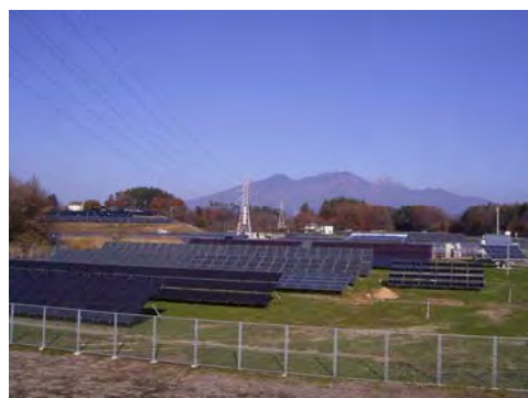
北杜サイトの全景。 当サイトに国内外で量産されているほとんどのメーカーの太陽電池が設置されている。
