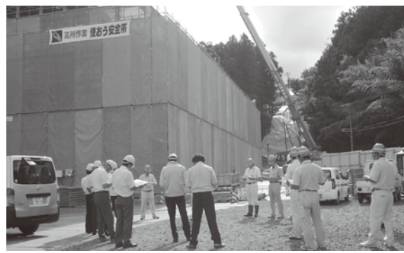
建設中の下り松ポンプ場を調査
