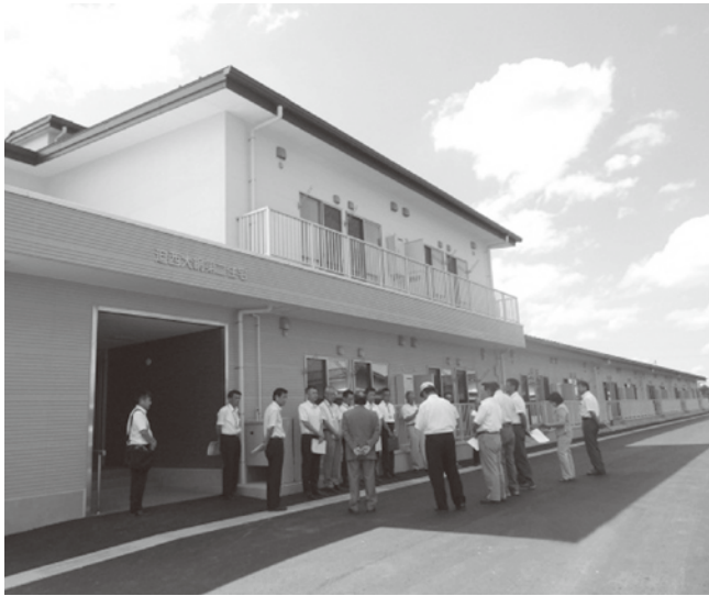
完成した災害公営住宅（迫西大網第二住宅）
