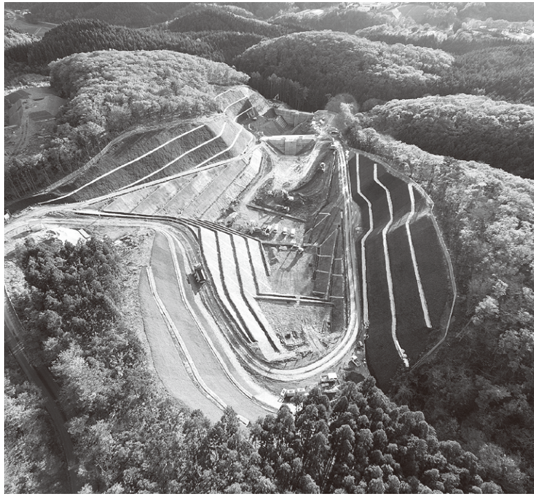
建設中の第二最終処分場埋立地(豊里町笑沢地内)
