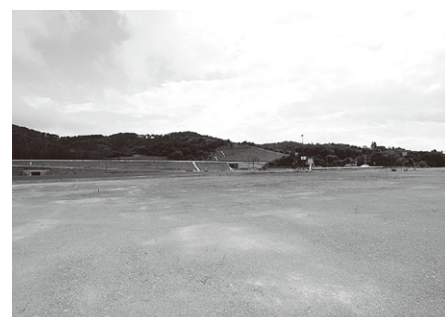
道の駅 三滝堂建設地（東和町米谷）
