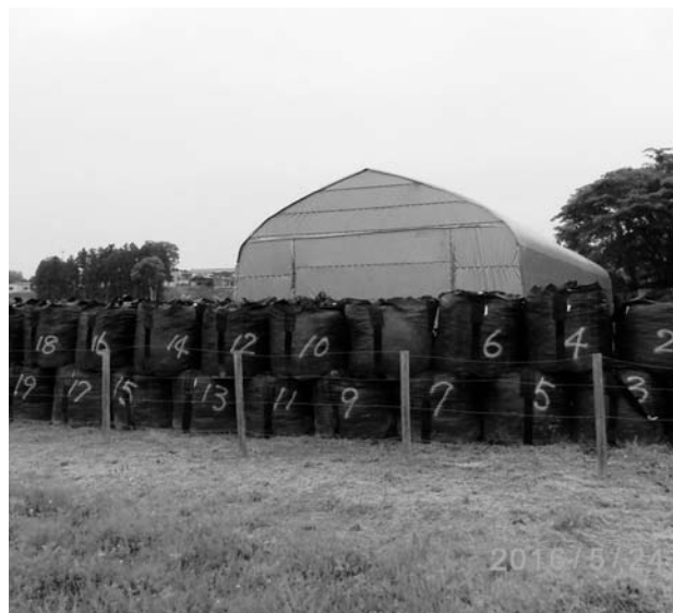
指定廃棄物の保管庫
