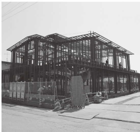
建設中の災害公営住宅 (迫西大綱第二住宅)
