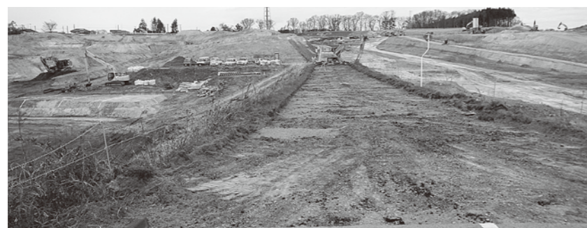
造成工事が進む(仮称)長沼第二工業団地
