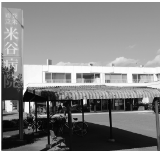
建て替えが予定されている米谷病院
