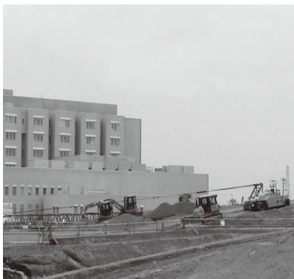
工事中の三陸自動車道のIC（石巻赤十字病院付近）
