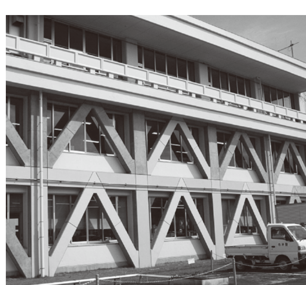
21年度に耐震補強された本庁舎
