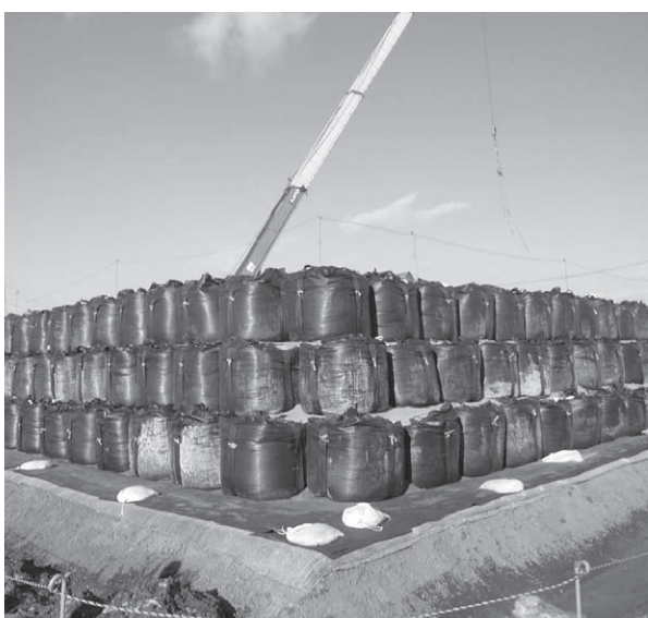
南相馬市の除却土置場
