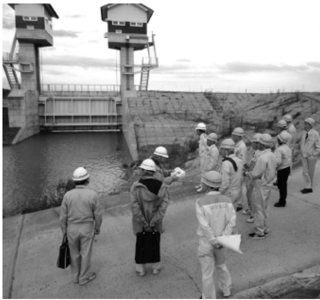
長沼ダムの砂原水門
