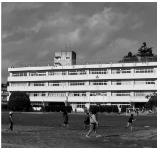
早く洋式トイレに(登米小学校)
