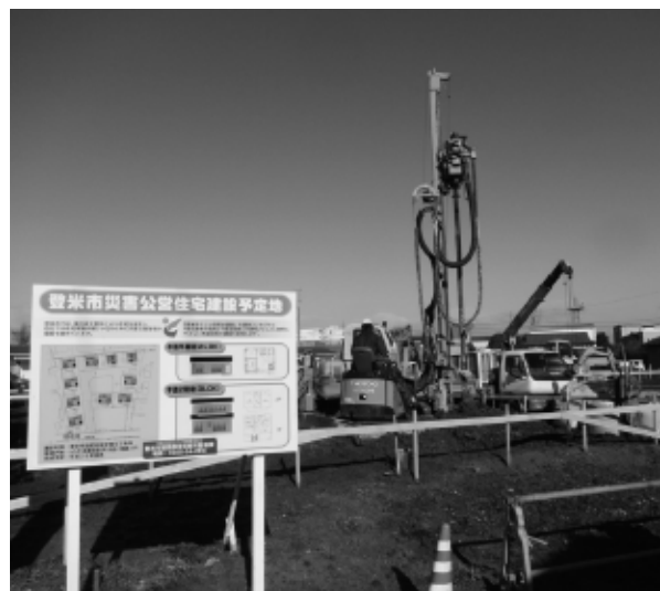
着工した災害公営住宅
