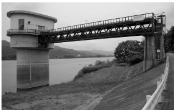
下り松取水塔
