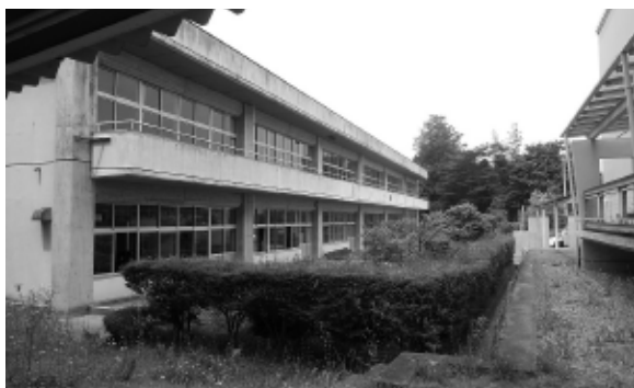
森公民館として活用される旧森小学校
