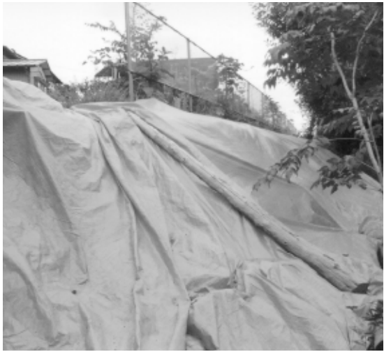
シートで覆われた被害現場
