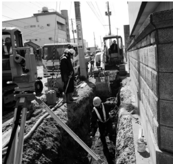
下水道の災害復旧工事
