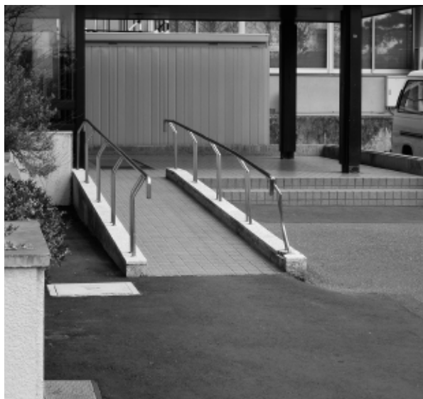
車椅子などに配慮した整備がされているか
