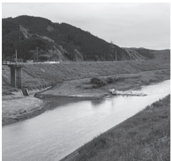
津山町整備地への水取り入れ口
