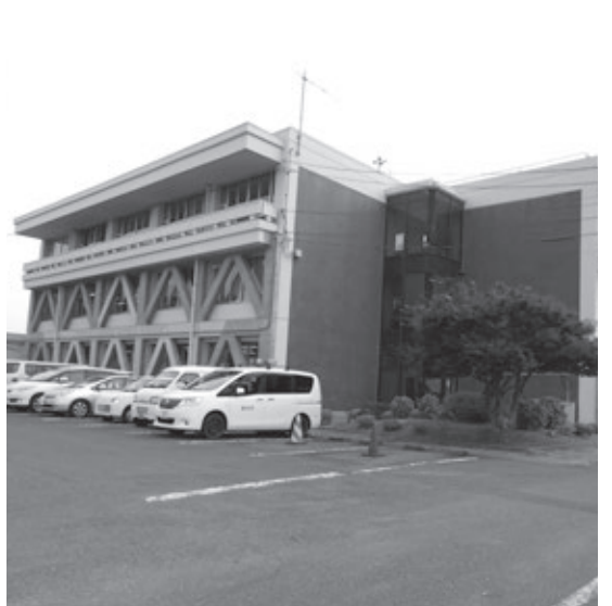
基礎杭健全度の低いエリアが集中する北西側
