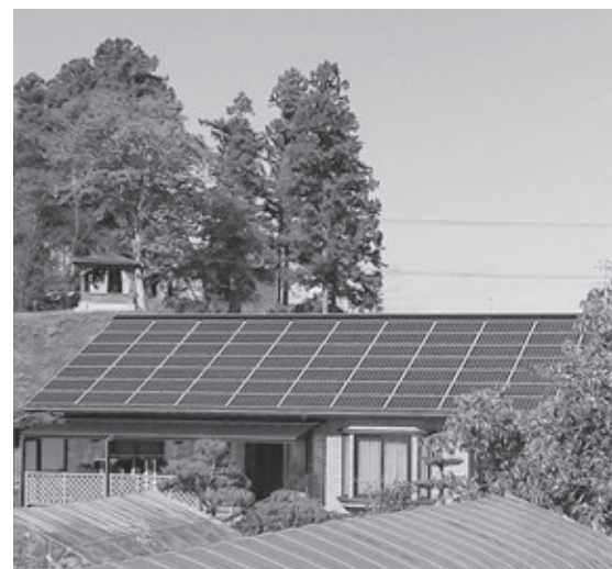
秋の陽光を浴びてフル稼働 (佐沼地内の太陽光パネル)
