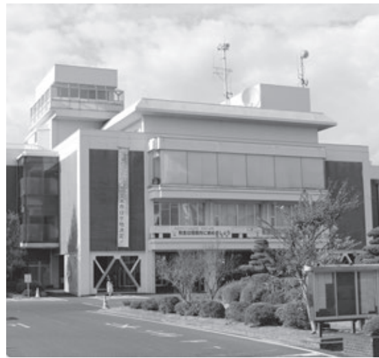
本庁舎は災害対策の指令本部となる重要な施設
