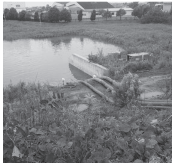
水中ポンプによる強制排水
