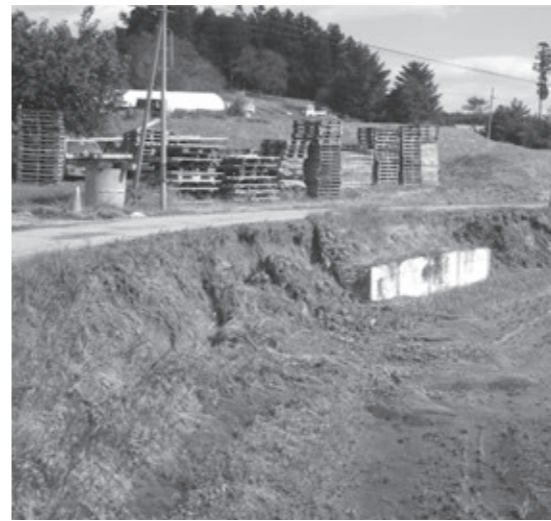
台風第19号により崩落した道路の法面
