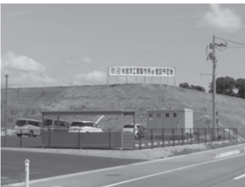
株式会社旭洋工業製作所の建設予定地
