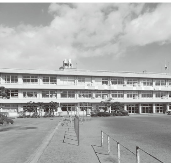
活用を検討中の米岡小学校
