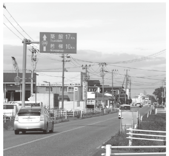
安全対策が必要な国道398号線 (迫町西館から舟橋)
