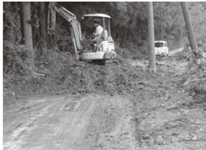
生活道路の土砂撤去(東和町米川)
