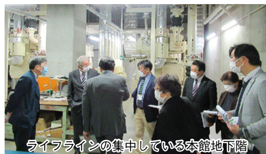
ライフラインの集中している本館地下階
