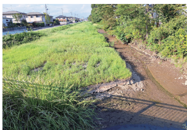
いつ終わる土砂撤去
