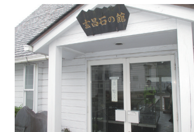
建て替えが見込まれる玄昌石の館
